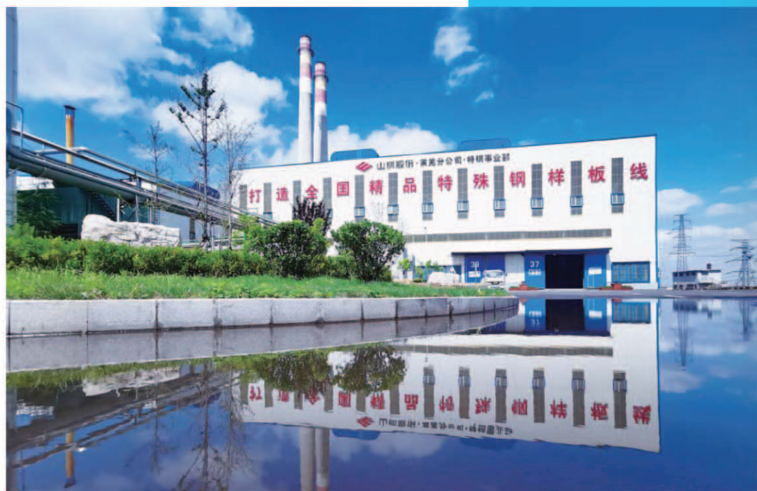
山钢股份莱芜分公司特殊钢产线厂房外景
